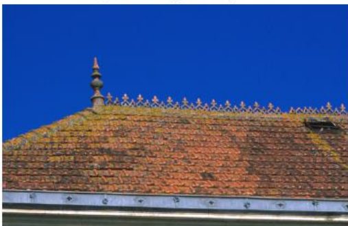
Toit en tuiles losangées avec un épis de faîtage
