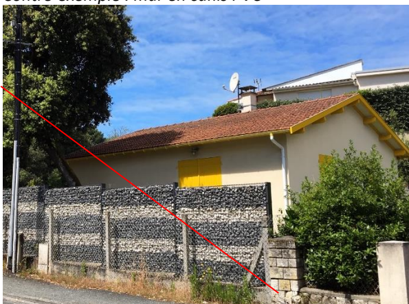
Contre-exemple : mur en gabion de pierre
